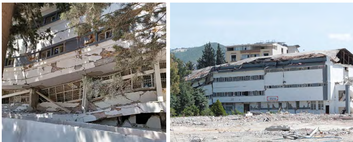
Fig. 17. Collasso edificio per danni a livello dei pilastri del piano terra di un intero blocco.
