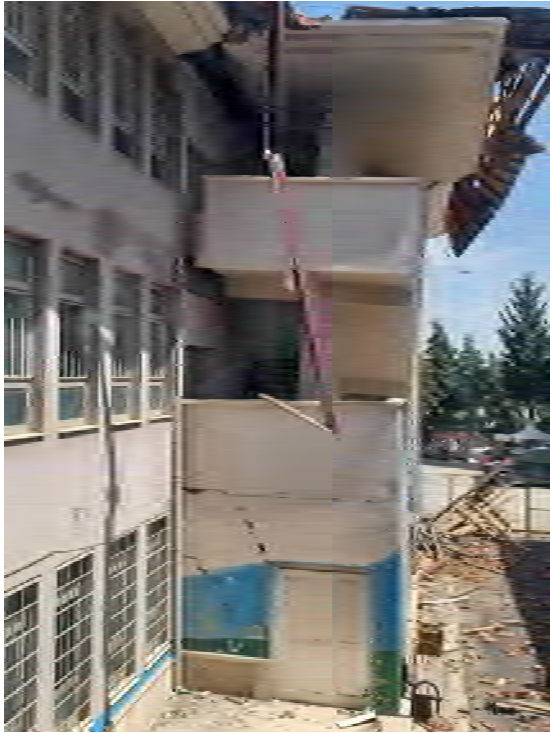
Fig. 10 Crollo incipiente (sinistra) e totale (destra) dei vanni delle scale di emergenza esterni.
