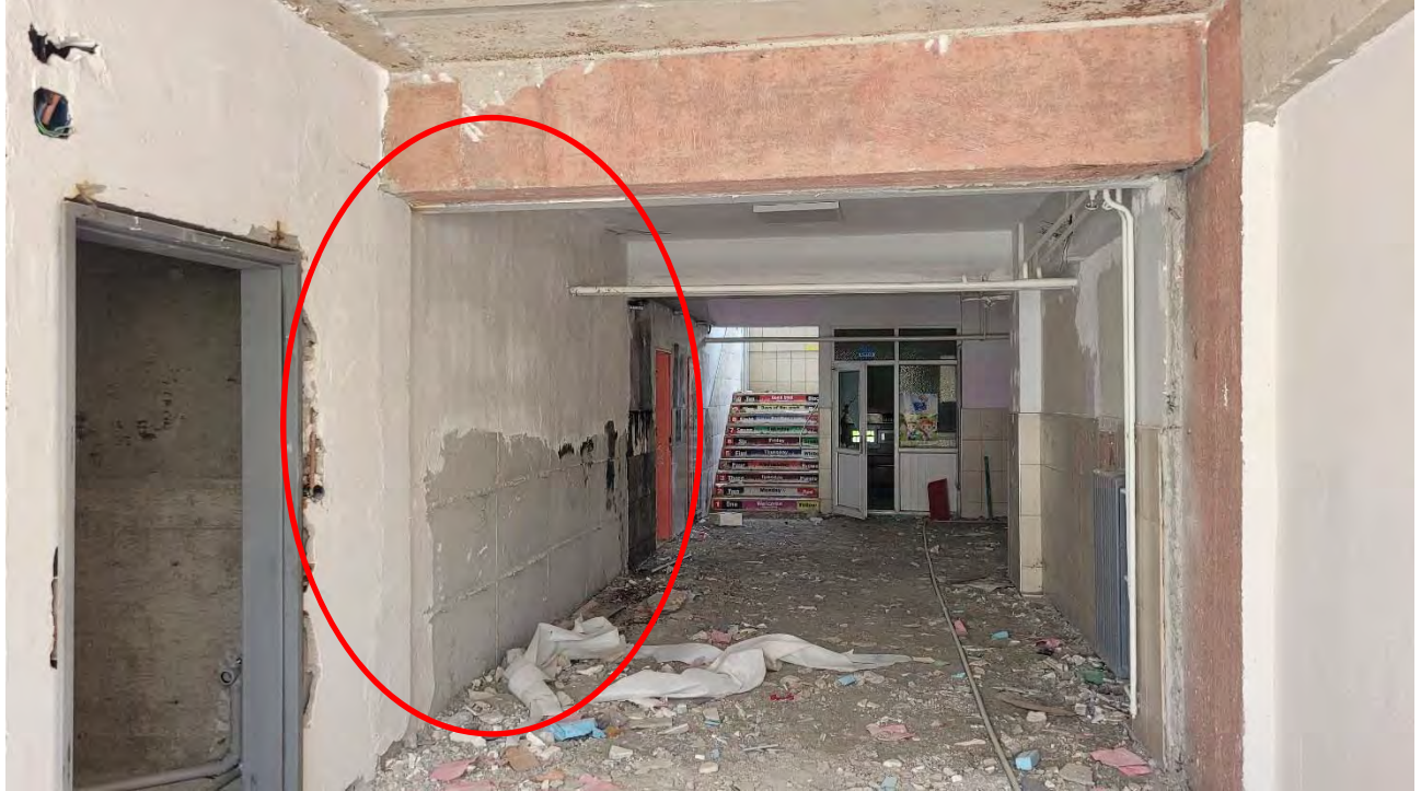
Fig. 14: Inserimento di setto in c.a.
