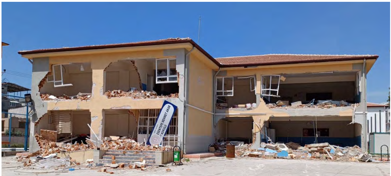
Fig. 11. Ribaltamento fuori piano di tamponature e tramezzi di entrambi i piani.
