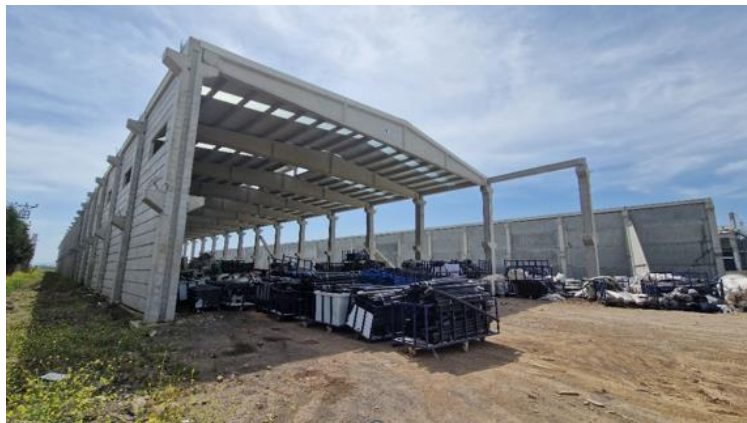
Fig. 13 – Vista laterale della struttura.
