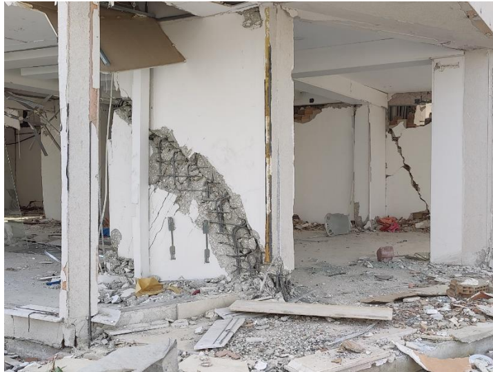
Fig. 11: crisi a taglio di un setto in c.a.
