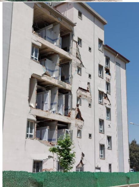
Fig. 5 Grave danneggiamento tamponature, con espulsione delle stesse, in corrispondenza dei telai perimetrali su due facciate dell'edificio. Dissesto copertura in legno, con caduta di tegole.
