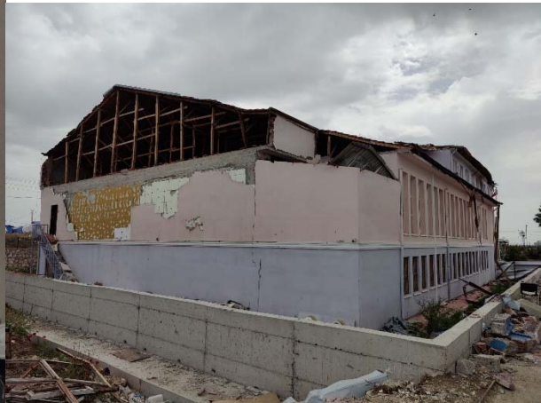
Fig. 6 -Vista frontale dell'edificio, lesione flessionale sulla trave, danneggiamento della tamponatura, danneggiamento della copertura.
