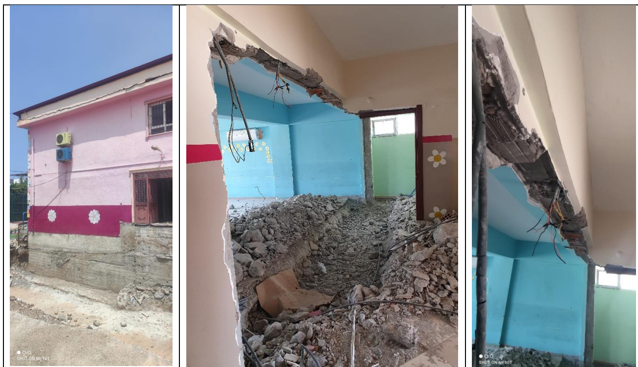
Fig. 5 – Intervento di realizzazione di setti in c.a. in corso di realizzazione immediatamente prima dell’evento sismico: scavo in fondazione per il consolidamento delle stesse (a), rimozione della
